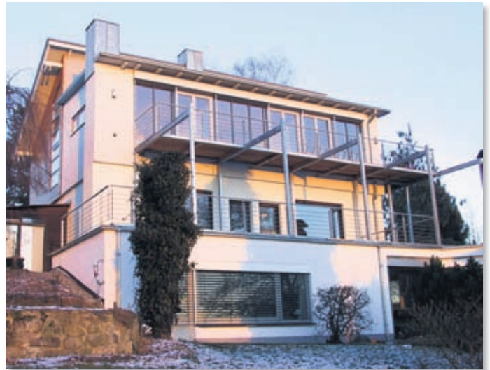
Das gleiche Gebäude nach der energetischen Sanierung und architektonischen Umgestaltung (Foto: nh/Gerlach)
