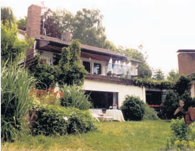
Ein Gebäude vor der energetischen Sanierung und architektonischen Umgestaltung (Foto: nh/Gerlach)
